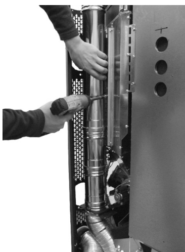
Fig. 64 - Fastgørelse af rør
